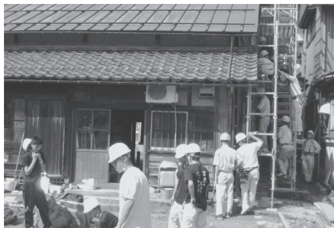
若狭屋の改修
